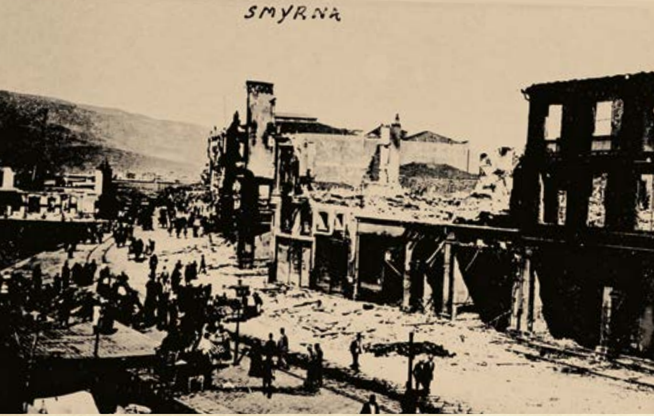
Μετά την καταστροφή.
